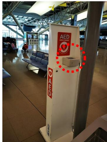
AED裏面に両面テープ固定。ケーブルモールで固定。ポール下部の電源利用（ゴミ箱側）。
