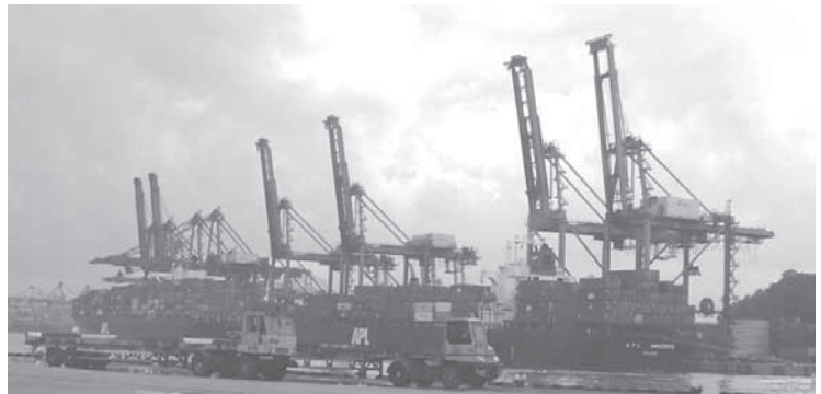
写真-3 ガントリークレーン
