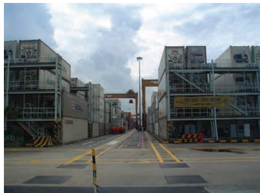
コンテナ・ヤード
