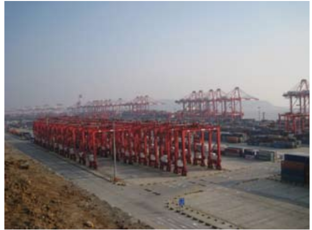
コンテナバースクレーン群
