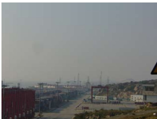
現在稼働中のバースと工事状況 (サンドコンパクション船団)
