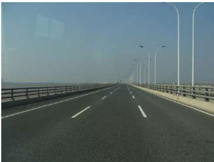
東海大橋（上海市内に向かって撮影）
