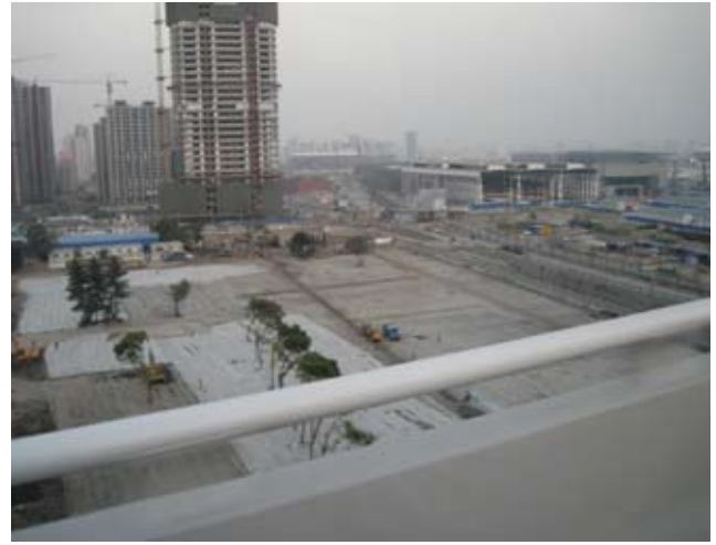
工事中のホテル
