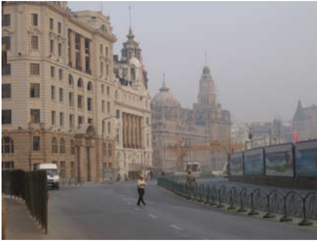
工事中の黄浦江西岸
